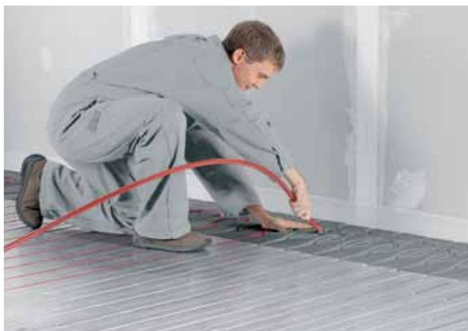
Lors de la pose, veiller à ne pas écraser les zones de demi-tour. Enfoncer le tube au fond de la plaque afin qu'il soit correctement maintenu. Il peut être nécessaire d'utiliser des pontets de fixation pour maintenir le tube sur l'isolant dans les zones de demi-tour.
