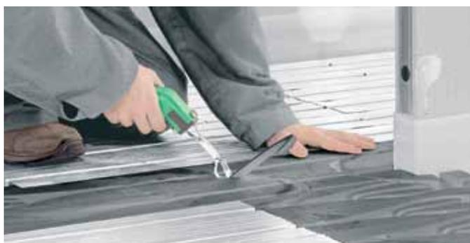
Dans les zones de raccordement (entre le circuit et le collecteur), pour recevoir le tube, il peut être nécessaire de réaliser des rainures supplémentaires à l'aide du fer à rainurer.
