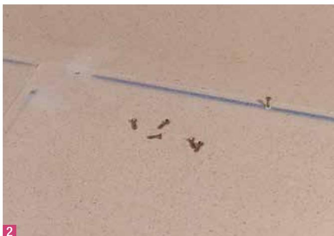
**2** Les dalles sont liaisonnées entre elles par vissage à l'aide des vis spécifiques DALSOL à raison de 8 vis par élément (5 sur la longueur et 3 sur la largeur) en utilisant une visseuse à embout rétractable afin de ne pas blesser les tubes PER placés en dessous.
