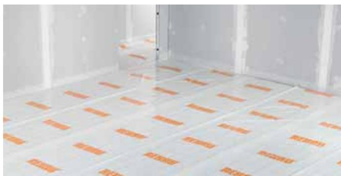
Procéder à la pose des plaques DAL SOL de gauche vers la droite en coupant les débords de chevauchement placés contre les cloisons de façon à avoir la totalité de l'épaisseur de la plaque à ces endroits. La découpe des plaques est effectuée à l'aide d'une scie égoïne ou d'une scie circulaire équipée d'un système d'aspiration.
