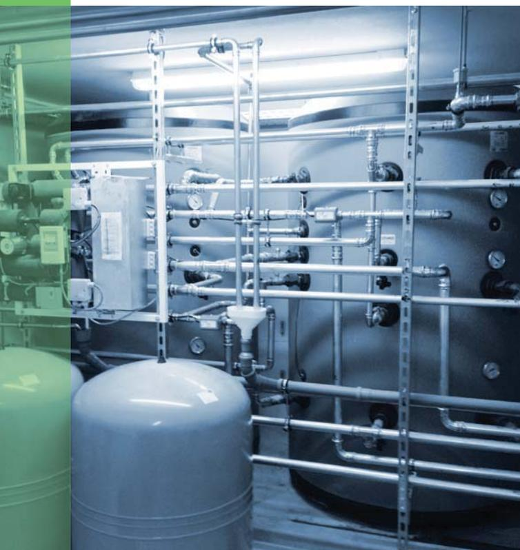
**BALLONS D'ACCUMULATION POUR CIRCUIT FERMÉ:** Ballons de stockage énergétique de **50 à 6.000** litres de capacité, pour circuits fermés de chauffage ou de réfrigération.
